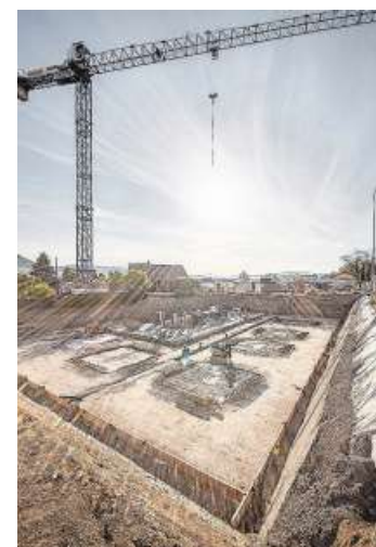
Blick auf die Schöfferwis-Baustelle in Kaltenbach. Bild: PD
